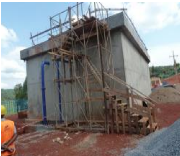
Costruzione di una torre d'acqua (REGIDES) ROBUKO
