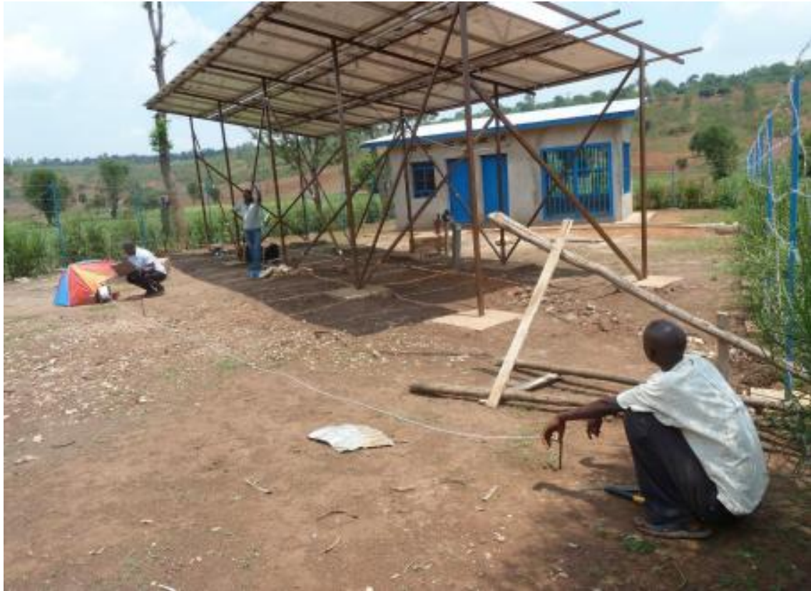
Esempio di una delle installazioni di pompe solari realizzate da ROBUCO.
